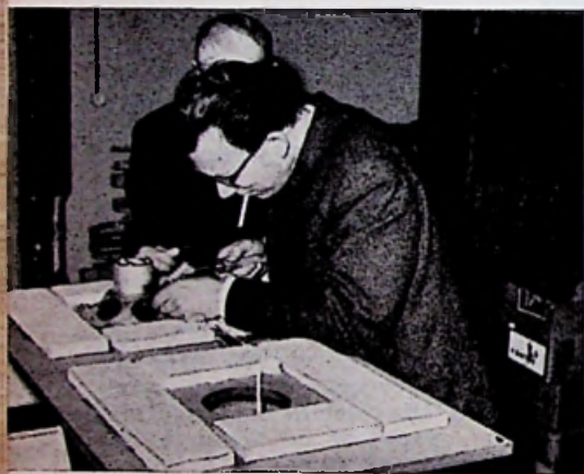
De luidspreker is op zijn paneel geschroefd en wordt van een (tijdelijke) aansluiting voorzien....
